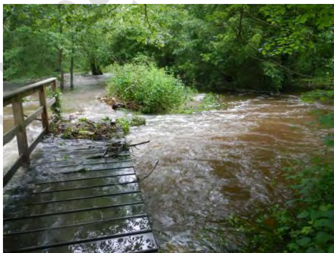
Figure 5 : la digue en rive droite du canal d'aménée au moulin Beaudon a été totalement surversée, les brèches ne suffisent plus à absorber le débit.
