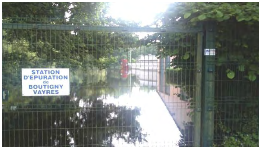
Figure 31 : Station d'épuration de Boutigny (arrêt complet)
