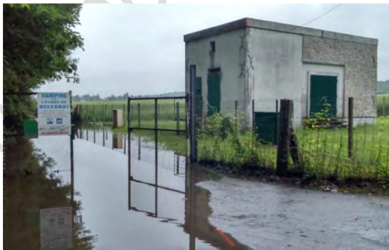
Figure 30 : Forage de Courdimanche – montée des eaux jusqu'au pied du forage
