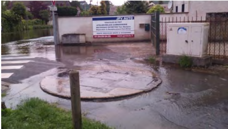
Figure 23 : Poste de l'Ile Amet à Maisee (arrêt complet et armoire touchée)
