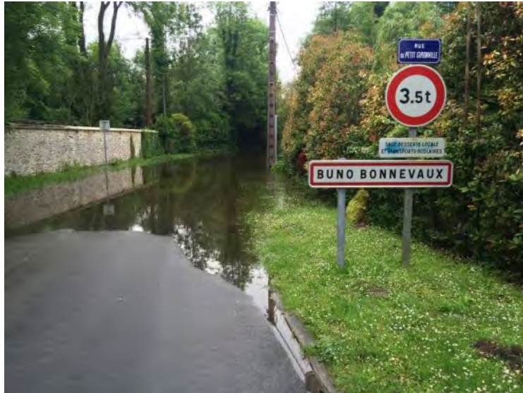
Figure 15 : la rue de l'Essonne au Petit Gironville et qui barre en travers la vallée, a été surversée sur près de 300 mètres.
