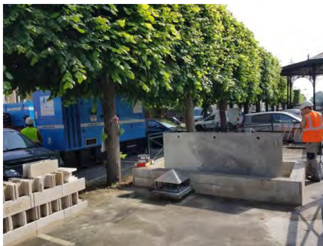
Figure 40 : Poste Aristide Briand à Corbeil-Essonnes (non impacté mais protection de l'armoire et groupe électrogène amené en prévision)
