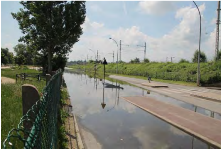
Figure 38 : Boulevard LeCouillard à Corbeil- Essonnes (remontée de l'Essonne via le réseau d'eaux pluviales)
