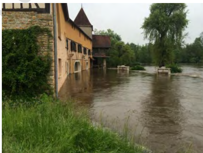
Figure 6 : au maximum de la crue, la totalité du site du moulin Touveau était sous l’eau
