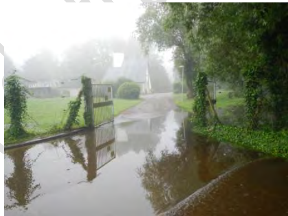
Figure 35 : station d'épuration de Baulne (coupée en électricité mais alimentée par un groupe électrogène)
