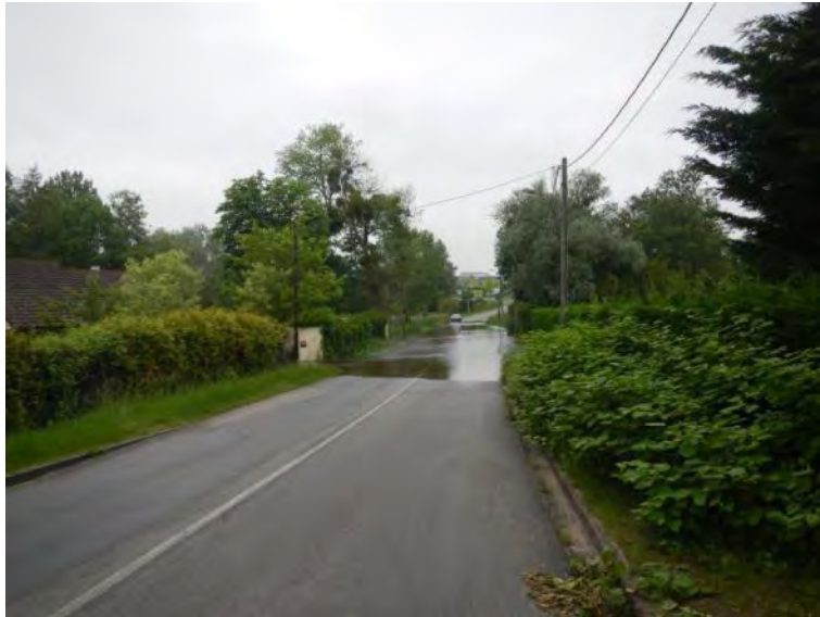
Figure 37 : la route de Ballancourt à Itteville
