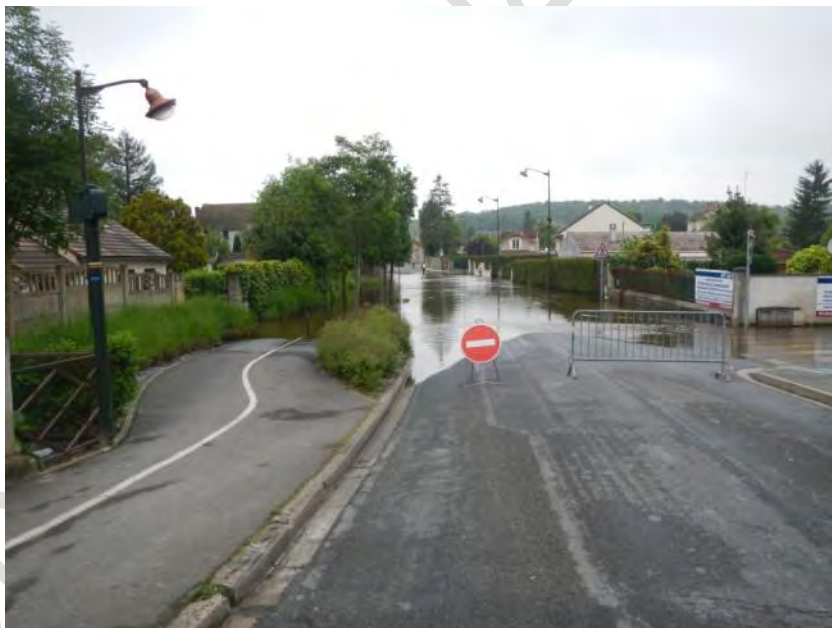
Figure 22 : L'avenue du Général de Gaulle à Maise et la surverse en rive gauche du bras gauche
