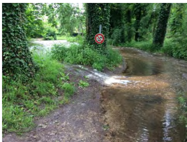
Figure 20 : une des nombreuses brèches qui se sont formées dans la digue droite du bras du moulin de Vicq à Gironville-sur-Essonne
